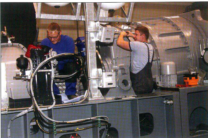
Die Montage einer Windkraftanlage zeigt die Komplexität des technischen Equipments und zeugt von der hohen Leistungsfähigkeit des Unternehmens und seiner Mitarbeiter
