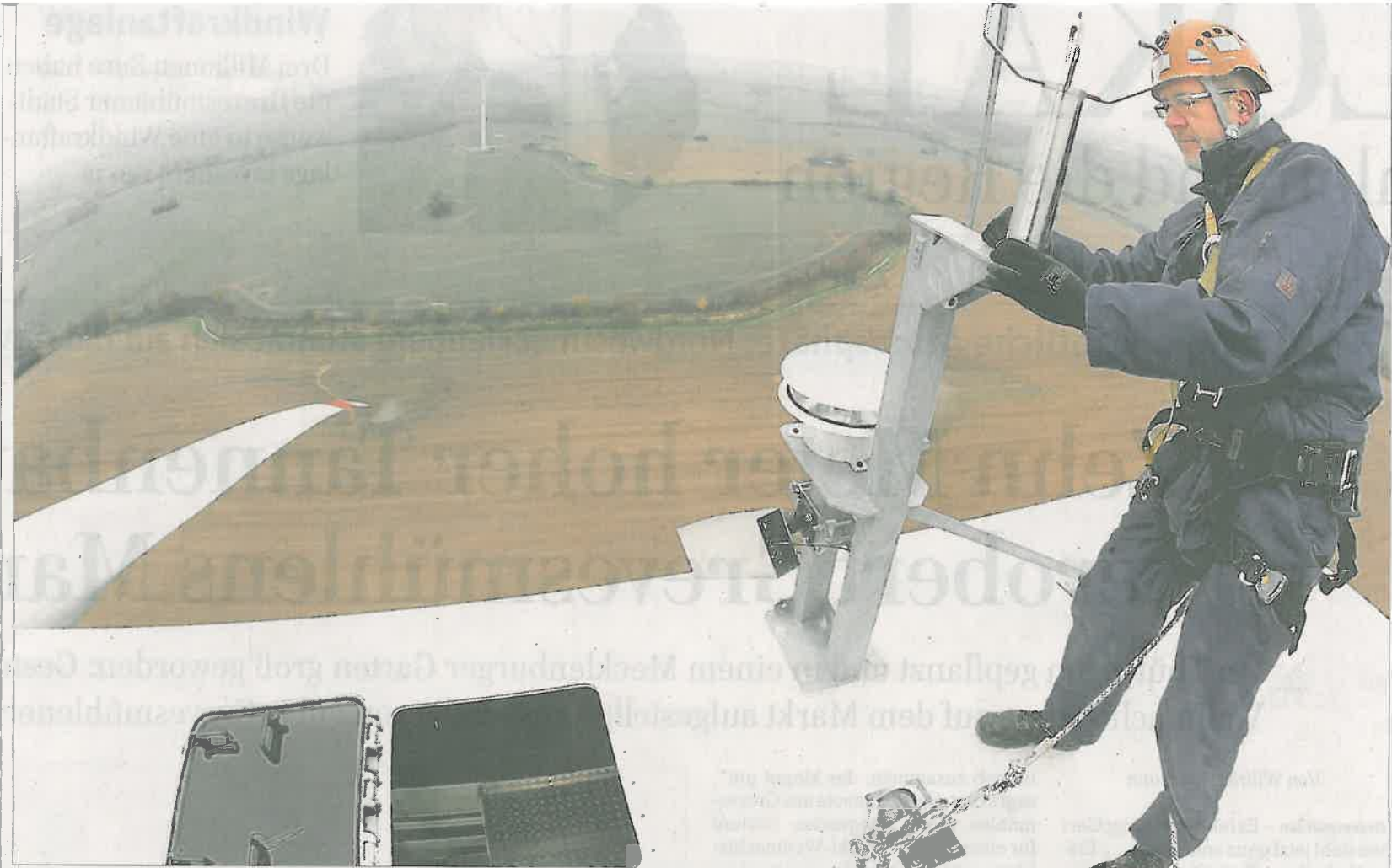
Auf dem Dach des Maschinenhauses einer Windkraftanlage K 100 (100 Meter Nabenhöhe) des Unternehmens Kenersys bereitet Thorsten Löw die Kontrolle des Ultraschallanemometers zur Messung von Windrichtung und Geschwindigkeit vor. Im Hintergrund steht die Anlage der Stadtwerke. Fotos: dpa
