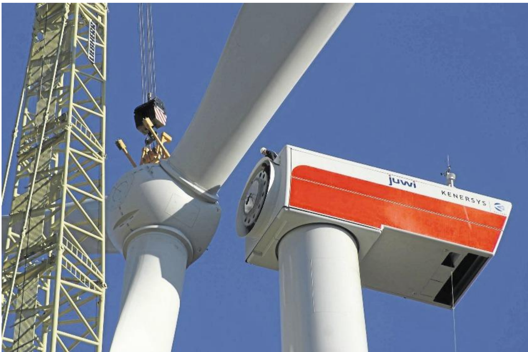
Aufbau einer Windkraftanlage des münsterschen Unternehmens Kenersys: Rund 100 Windräder hat die noch junge Firma weltweit bereits installiert.
